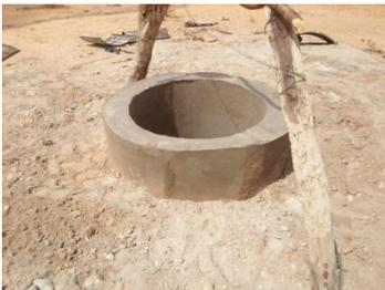
Nach der Trocknung des Betons wurde der Brunnen wieder dem Terrain angeglichen. Es fehlt nur noch die Betonierung um den Brunnenrand am Boden, was die Baucrew in der Zwischenzeit erledigt hat.
