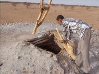
Der Brunnen „Akatama“ befindet sich in der Region Azawagh und ist 38 Meter tief. Es ist ein stark frequentierter Ziehbrunnen, der noch keinen hohen Rand aufweist. Während der Jahre sind auch hier im Schacht Auswaschungen durch das Pendeln der schweren Wassersäcke entstanden.
