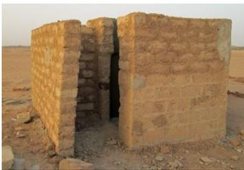
Während den Sommerferien, wurde die Latrine ausgebaut und die Mauern erhöht. So ist der Sichtschutz auch für grössere Schüler gewährleistet. Neue Abdeckungen wurden gefertigt und das Dach entfernt.
