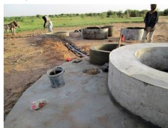
Nachdem der ganze Brunnenaufbau getrocknet ist, werden die Tränkebecken für das Vieh gebaut und mit Leitungen verbunden. So können gleichzeitig gruppenweise Tiere getränkt werden. Am Schluss werden die grossen Astgabeln mit der Seilrolle in die ausgesparten Löcher betoniert.
