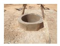
Nach der Trocknung des Betons wurde der Brunnen wieder dem Terrain angeglichen. Es fehlt nur noch die Betonierung um den Brunnenrand am Boden, was die Baucrew in der Zwischenzeit erledigt hat.
