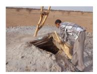
Der Brunnen "Akatama" befindet sich in der Region Azawagh und ist 38 Meter tief. Es ist ein stark frequentierter Ziehbrunnen, der noch keinen hohen Rand aufweist. Während der Jahre sind auch hier im Schacht Auswaschungen durch das Pendeln der schweren Wassersäcke entstanden.
