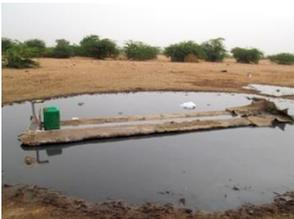
Diese Wasserstelle ist für die ansässige Bevölkerung wertvoll. Sie dient als Tränke für die Tiere, als Waschplatz und direkt vom Hahn als Trinkwasserquelle für die Familien. Leider ist der Beton mehr als marode und die Hälfte das kostbaren Nass fliesst in die Wüste, verdunstet und versickert.
