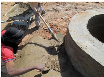
Die Umgebung wird eingeebnet und betoniert. So verhindert man eine Unterspülung des Randes durch überschwappendes Wasser aus den Säcken während des Tränkens der Herden.
