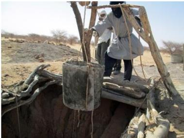
Im Gegensatz zu den letzten zwei Ziehbrunnen im Herbst 2017 können die Wände dieses Brunnens nach dem Ausbessern mit Betonringen verstärkt werden – die Herstellung der gebogenen Maurersteine fällt somit weg. Trotzdem muss jede Schalung, der benötigte Beton und die Steine für die Instandsetzung mit Seilen oder einem Kessel in den Schacht hinunter gelassen werden.
