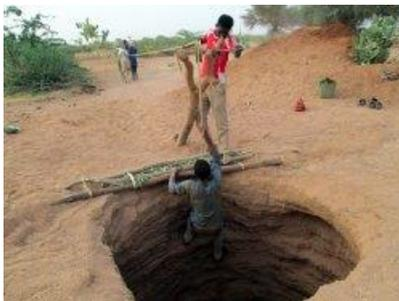
Dieser baufällige Ziehbrunnen ist 25 Meter tief und befindet sich in der Region Gougaram. Die unbefestigten Ränder bröckeln, füllen den Grund langsam aber sicher mit Geröll und sind für Mensch und Tier eine Gefahr. Nachdem wir die ersten Fotos dieses Brunnen begutachtet haben, beschlossen wir Imbilaou zu helfen und organisierten unsere bewährte Baucrew.
