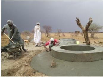
Die werden Brunnenrand mit einer Betonplatte verstärkt und das Tränkebecken für die Tiere erstellt.
