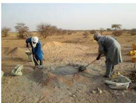
Das „dreckige“ Brackwasser wird zum Betonmischen verwendet, denn dafür reicht es allemal!
