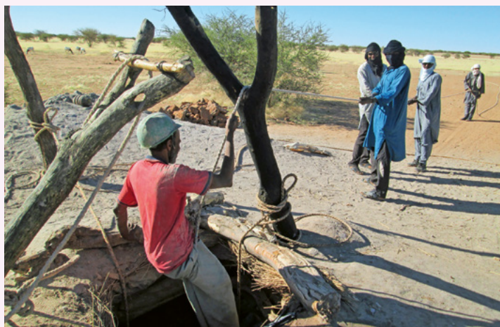
Behutsam wird der Brunnenmeister Alkassane in den Schacht hinuntergelassen.
