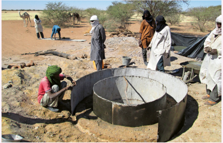
Die Schalungsringe werden am Brunnenrand angepasst.
